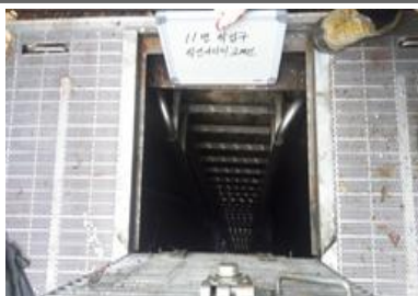
#11 작업구 수직사다리 현황
