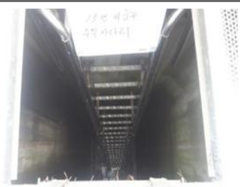
#14 작업구 수직사다리 현황
